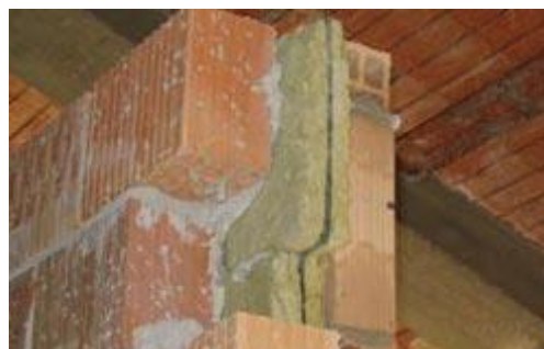
MURATURA DIVISORIA TRA APPARTAMENTI
