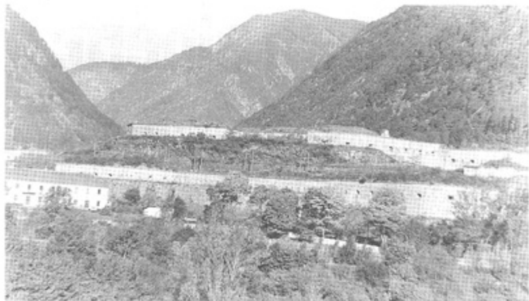
Il forte militare, abbandonato da qualche anno, dovrebbe passare in comodato dal Demanio al Comune
