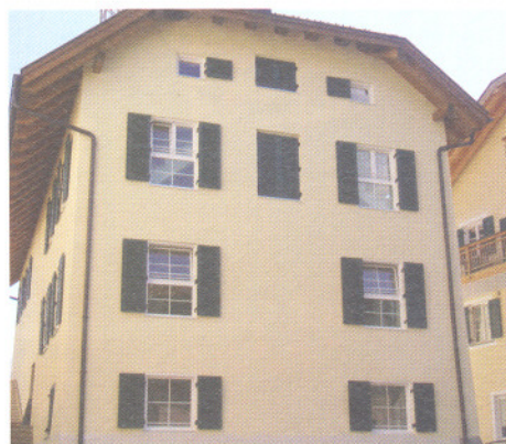
Die sanierte Westansicht des ehemaligen Knabenhauses
