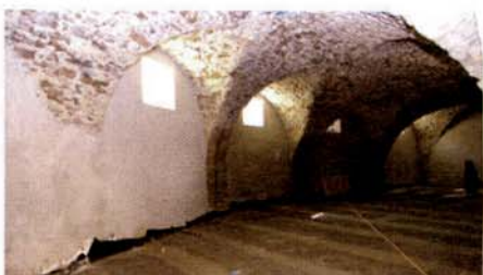
Einer der wiedergewonnenen gewölbten Keller
