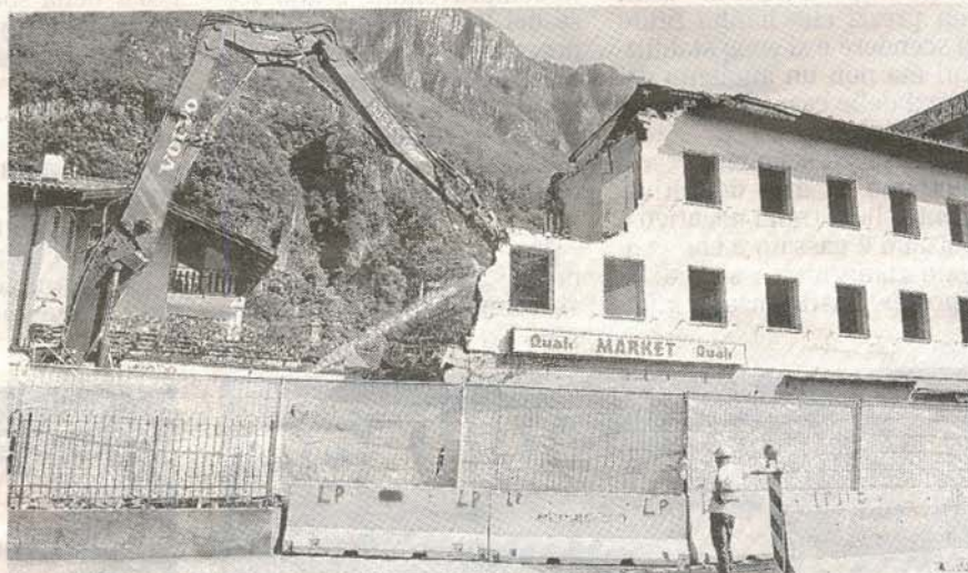
La ruspa in azione ad Oltrisarco, sopra come diventerà la zona recuperata
